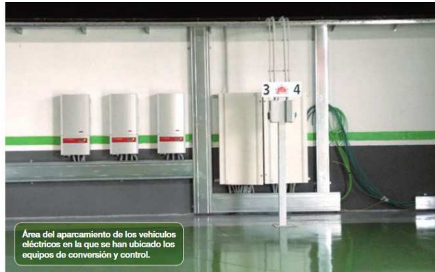
Figura 51. Área de aparcamiento [57]
