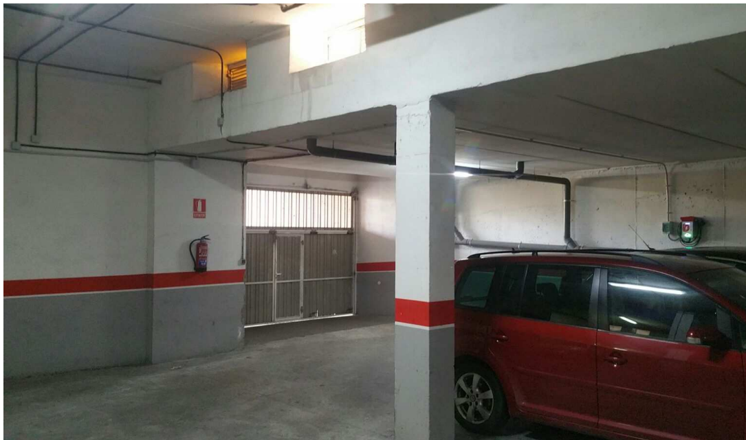
Figura 42. Instalación comunitaria de LuGEnerGy con WALLBOX [55]
