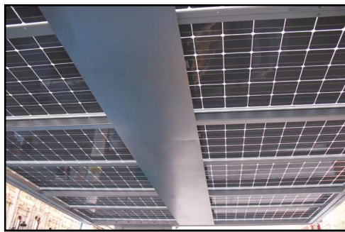
Figura 55. Marquesina fotovoltaica para apoyo del sistema de carga SAVE (izquierda) y detalle de paneles fotovoltaicos (derecha) [56]
