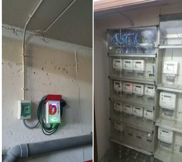
Figura 41. Punto de recarga y cuarto de contadores [55]
