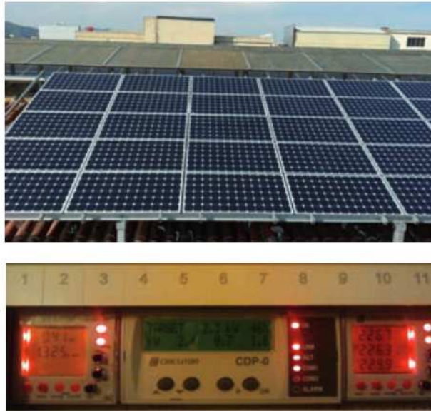
Figura 50. Vista parcial del campo solar y detalle del modulador de potencia CDPO que realiza el control con inyección cero [57]
