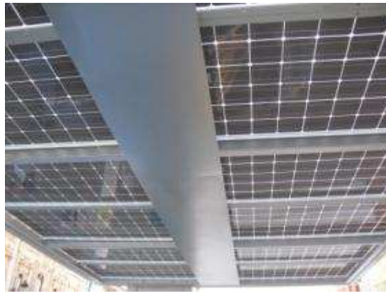
Figura 56. Instalación de carga de vehículos eléctricos (arriba) y detalle de paneles fotovoltaicos en la Marquesina (abajo) [56]
