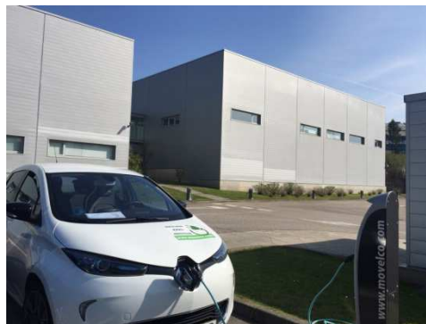
Figura 47. Instalación de punto de recarga en el Centro Tecnológico del automóvil [35]
