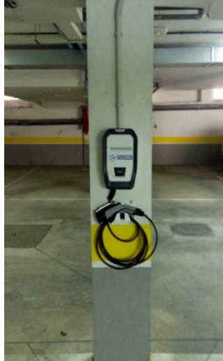
Figura 44. Punto de recarga CIR Ehome en parking comunitario [35]
